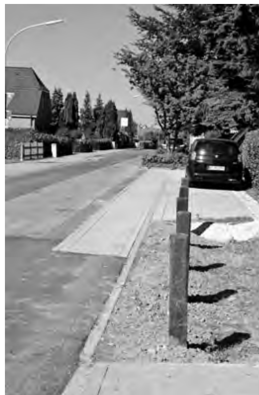
Ein runderneuerter Steinredder -bis zum Haidkamp/Am Stein.
